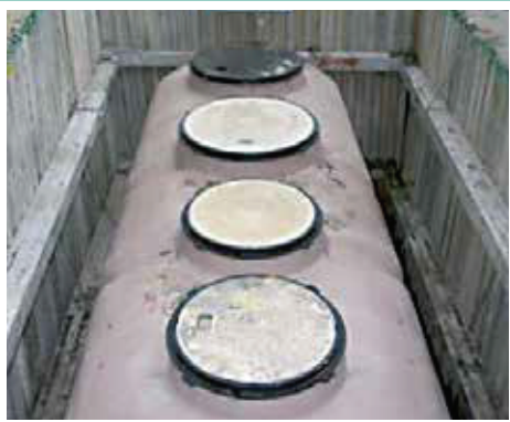
浄化槽設置工事
