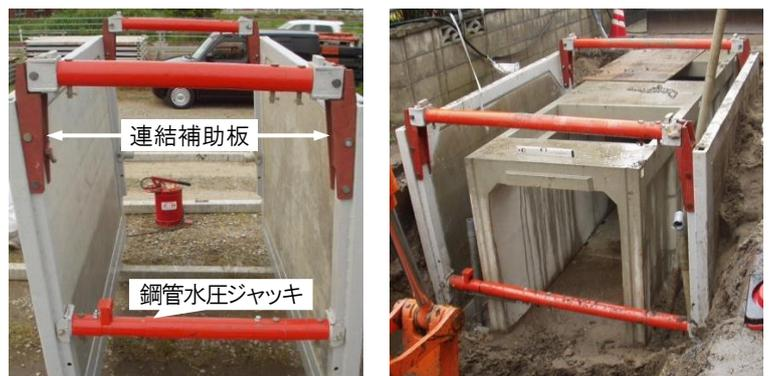
連結補助板を取付ける事で上下の切梁間隔が広がり、余裕を持って大口径管の敷設作業が行えます。
