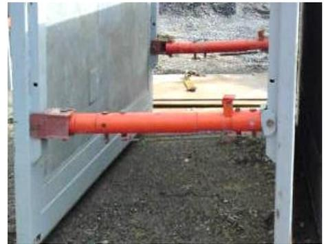
鋼管パイプの中に水圧シリンダーを組み込む事で、下段の切梁及び捨て梁の撤去がスムーズに行えます。
