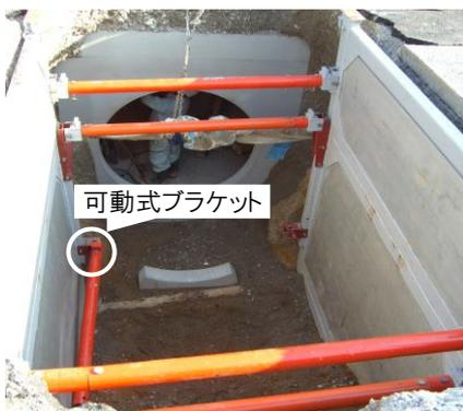
可動式ブラケットにより、鋼管水圧ジャッキのスイングが可能です。
