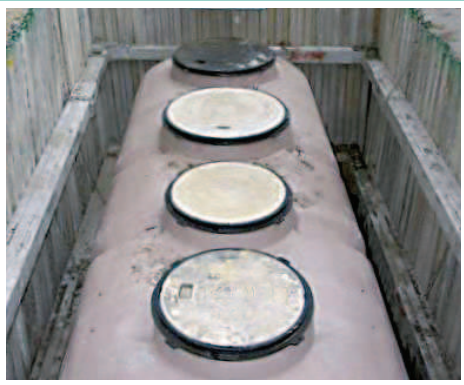
浄化槽設置工事
