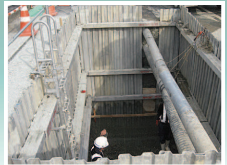
電線共同溝設置工事
