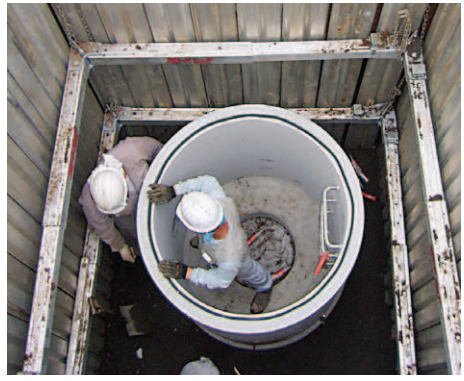
下水道マンホール設置工事
