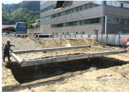
防火水槽工事
