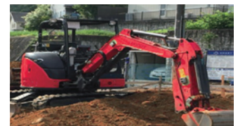
住宅基礎工事
