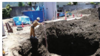
地盤改良工事
