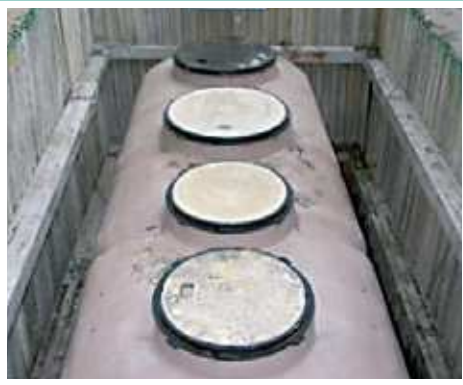
浄化槽設置工事
