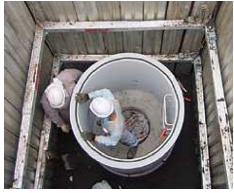
下水道マンホール設置工事
