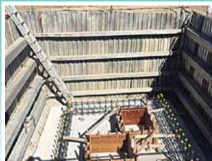
配水管不断水バルブ設置工事
