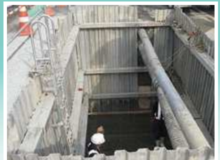
電線共同溝設置工事
