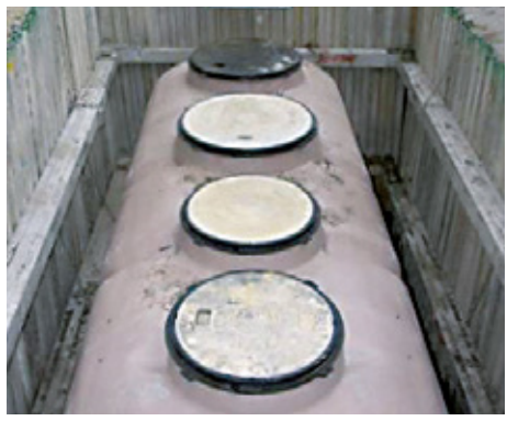
浄化槽設置工事
