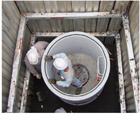
下水道マンホール設置工事
