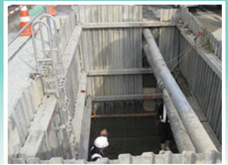
電線共同溝設置工事
